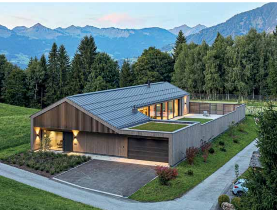
Noch schöner Wohnen geht kaum: Tolle Arbeit leistete das Team der Firma Martin Holzbau GmbH bei der Ausführung des Objektes.
