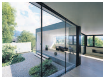
Der L-förmige Baukörper öffnet sich mit großen Glasflächen nach Osten.
