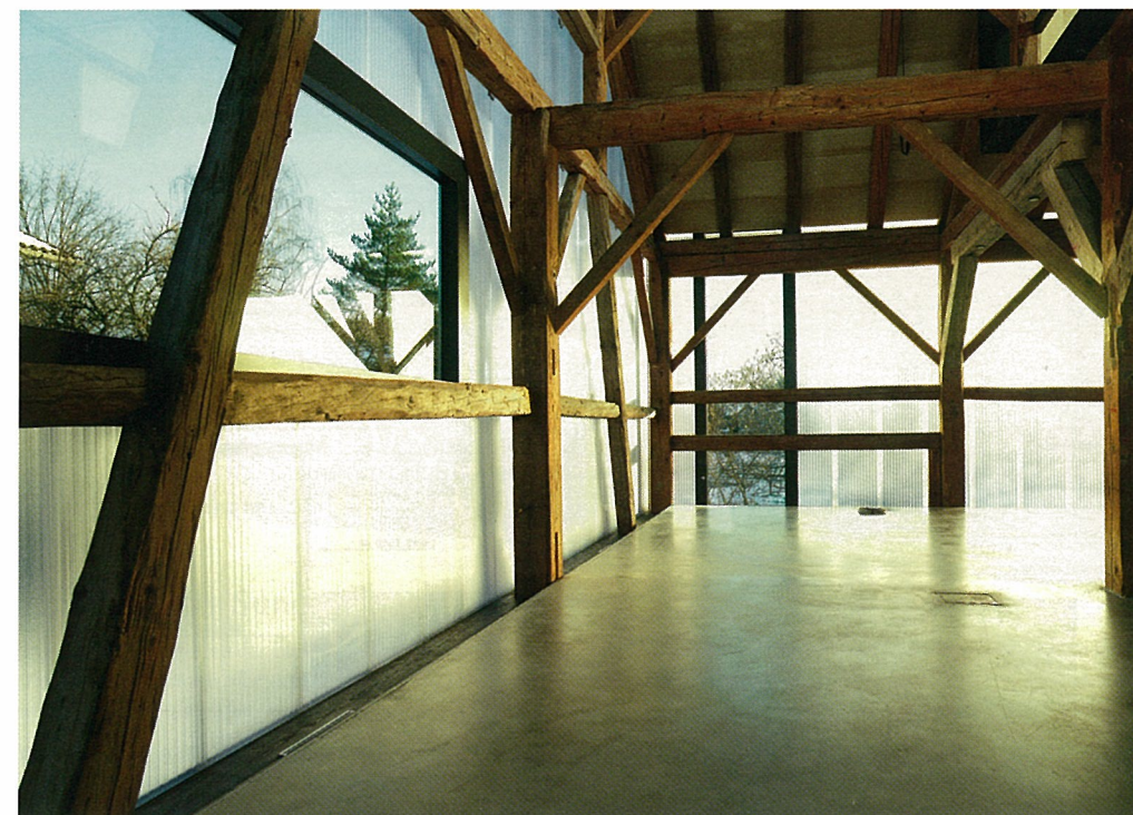
Profillose Polycarbonat-Hohlkammerpaneele bilden die thermische Hülle.
