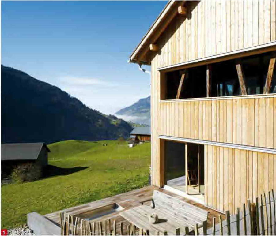
1 Die großflächigen Schiebeläden brachte die verfügbaren Rollenführungssysteme an ihre Grenzen. 2 Das bestehende Fichten- und Tannen-Altholz konnte fast komplett wiederverwendet werden.
