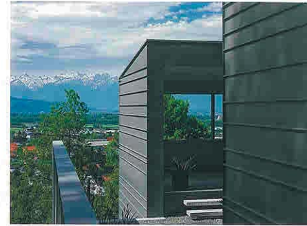
Aussicht mit Bergpanorama. Schiefergraue Rhein-zink-Fassade mit horizontalen Winkelstehfalzen.
