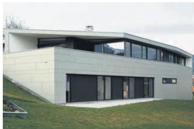
Die Kinderzimmer im Erdgeschoß laufen im Grünen aus.
