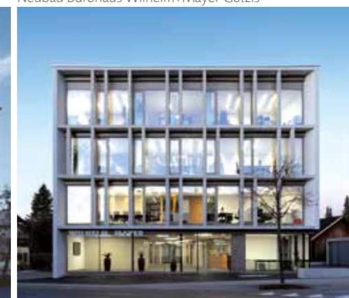
Neubau Bürohaus Wilhelm+Mayer Götzis
