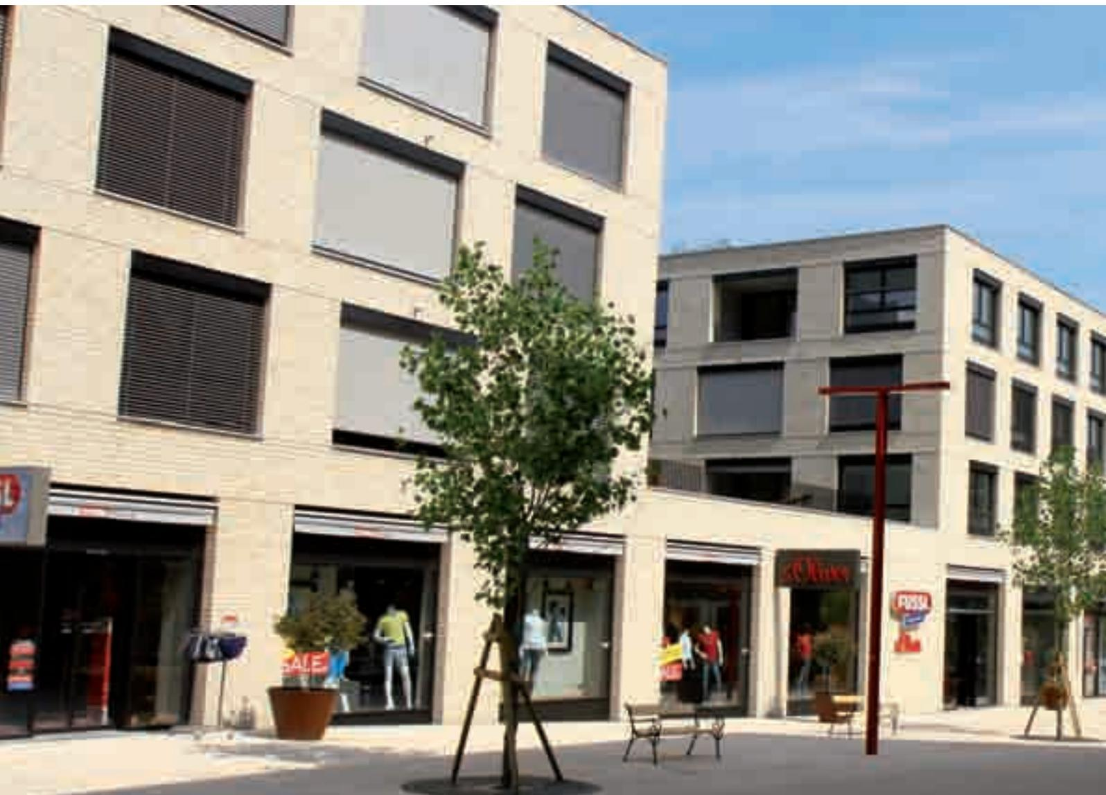
Die Fassade der viergeschossigen Baukörper besteht aus einer hellen Klinkerriemchenverkleidung mit leicht besandeter, genarbter Oberfläche. Die vorspringenden Riemchen bei den Geschossdecken gliedern die Fassade und geben dieser strukturellen Tiefe. Es wurden Holz-Aluminiumfenster mit hochwertiger 3-Scheiben-Verglasung eingebaut.
